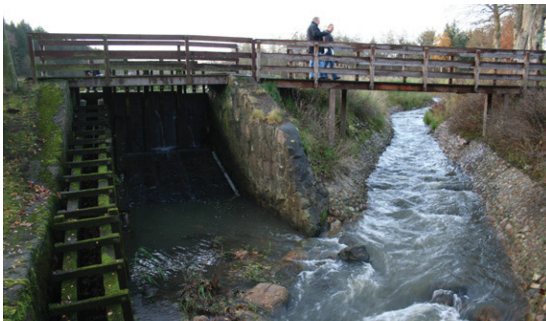
Mødet mellem frislusen og omlø- bet, hvor det gamle modstrømspas er be- varet. En stenrække er udlagt, der afspær- rer frislusen for at sikre at unge ål ledes ind i omløbet.
