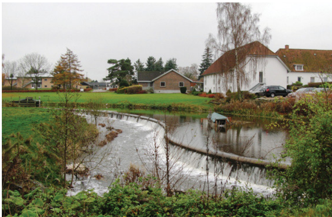
Overfaldskanten ved Brobyværk mølle er etableret med en spunsvæg beklædt med flækkede kampesten. Den hvide bygning i baggrunden er kroen.
